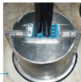
地基中的水下电缆穿隔。
