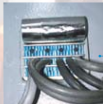
电位均衡的 PE 穿隔以及附属设备的闪电防护。
