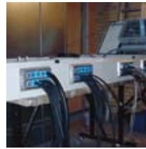
电位均衡的 PE 穿隔，吊舱控制室的标准系统。
