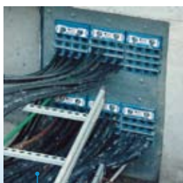
配有 EMC 和标准产品的岸上变流器站穿隔。
