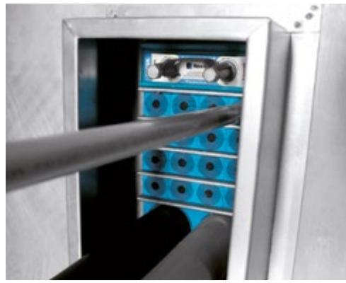
洛克赛克塑料管穿隔密封件有多种型号和尺寸。可适配圆形及方形的开口，适用于单根及多根塑料管道的穿隔密封。
