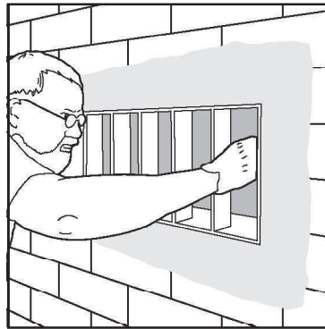
Nettoyer les ouvertures des résidus de béton.
