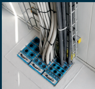
Centros de controle de motor
