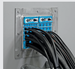
Centros de controle de motor
