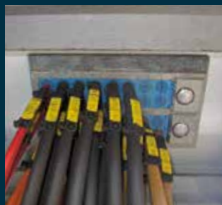
1. Systèmes de conversion de l'énergie
