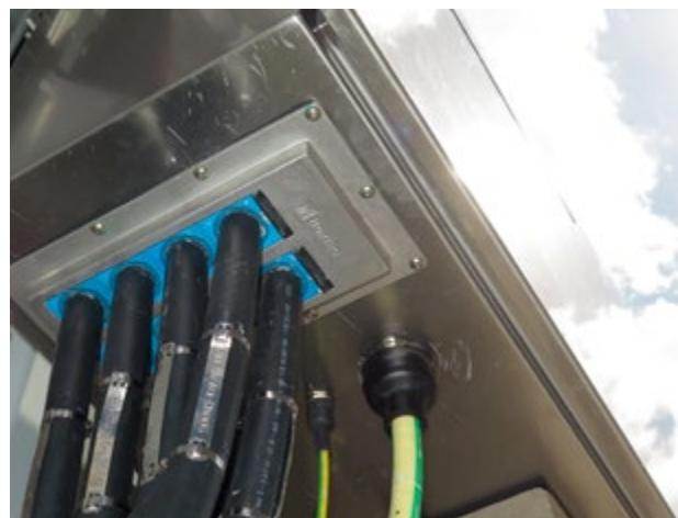
**Roxtec 可确保完美适配任何尺寸的电缆或管道。**
