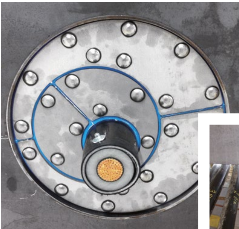
Эксцентриковые уплотнения Roxtec упрощают прокладку кабелей, которые сложно переместить.
