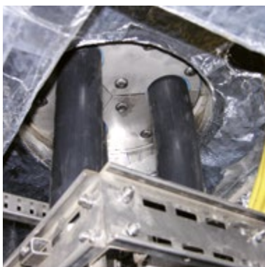
Специализированное уплотнение для распределительных устройств.
