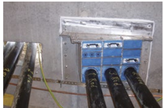
Рамы типа Roxtec GON являются разборными и могут быть установлены под углом в соответствии с ориентацией существующих кабелей и труб.
