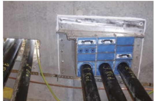
A moldura Roxtec GOH é adaptada para retrofit e angulada para adequar-se à orientação dos cabos e tubos existentes.
