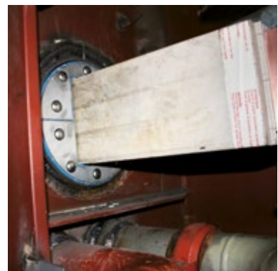
Solución por corte de agua de Roxtec para alojar barras o conductos de bus.
