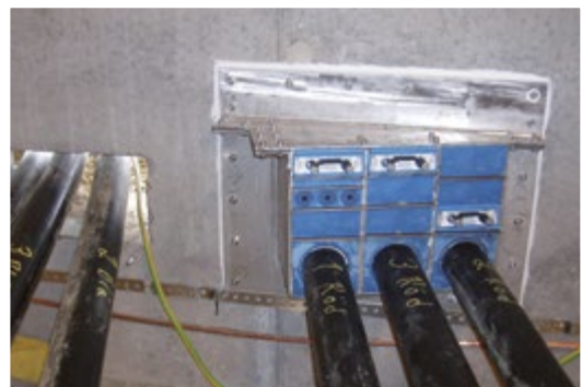
El marco Roxtec GOH se puede abrir y está en ángulo para adaptarse a la orientación de los cables y tuberías existentes.
