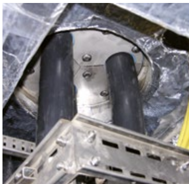
Maßgeschneiderte Dichtung für Anwendungen in Schaltanlagen.
