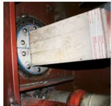
Die wasserdichte Lösung von Roxtec für Stromschienen.
