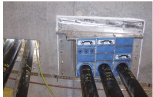
Der Roxtec GOH-Rahmen kann geöffnet werden. Er kann abgewinkelt werden, um zu der Ausrichtung vorhandener Kabel und Rohre zu passen.
