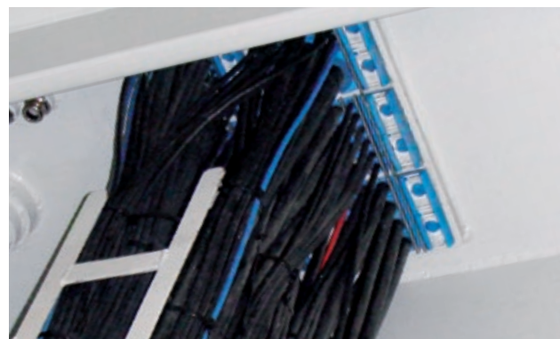
溶接されたRoxtec Sフレーム
