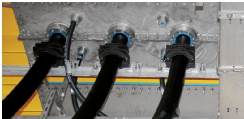
変圧器用のケーブルシールを備えた開閉可能な鋼製プレート
