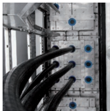
大口径ケーブルに使用された特別設計の Roxtec Hフレーム
