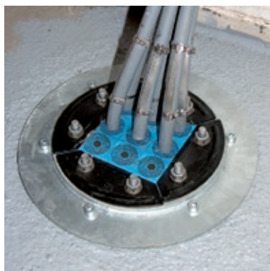
ボルト締めされたスリーブ内に設置されたRoxtec Rフレーム
