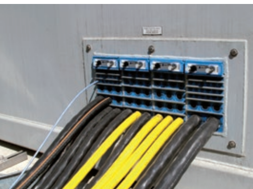
ボルト締めで取り付けられたRoxtec SFフレーム
