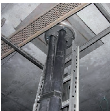
132 kVスイッチギアに使用されたテーラーメイド のHシール
