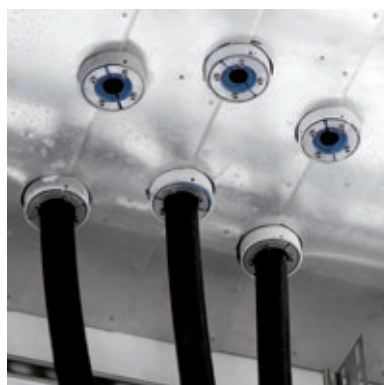
スイッチギアのケーブルに使用された Roxtec RSシール
