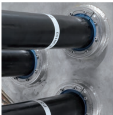
スリーブを使用して設置されたRoxtec RSシール
