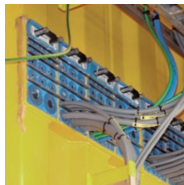
溶接されたRoxtec SFフレーム
