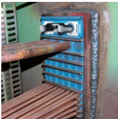
Рама Roxtec S обеспечивает ввод нескольких металлических труб через один квадратный или прямоугольный проем в палубе или переборке.
