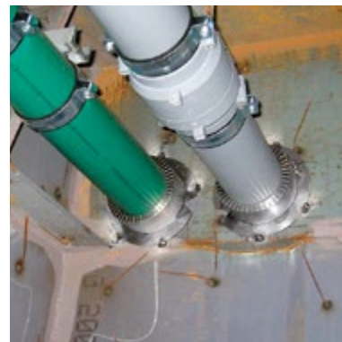
Roxtec Sleeve-it™ — огнестойкая герметизация вводов одиночных пластиковых труб; это решение разработано для одностороннего монтажа. Разборная конструкция является особым преимуществом как при реконструкции, так и при строительстве новых объектов.
