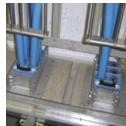
コアドリル孔の上に取り付けられたGKOフレーム。GKOフレームは既設のケーブルに最適です。
