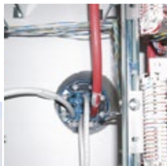
コアドリル孔に取り付けられたRフレーム。
