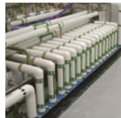
床を貫通するパイプを密閉するGフレーム。
