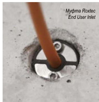
Выбивные гильзы Roxtec поставляются в трех различных типоразмерах.
