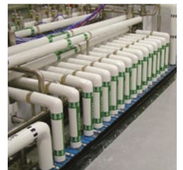
G Rahmen in einer Boden Anwendung, um Rohrdurchführungen abzudichten.
