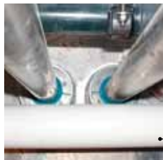
2個のRoxtec RSシールが、それぞれステンレス鋼パイプに使用されています。
