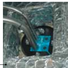
振動を抑制するRoxtec Rフレーム
