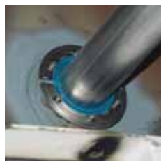
メイン・エンジン・ルームのパイプ用に使用されるRoxtec RSシール
