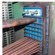
隔壁やデッキで複数のパイプを貫通処理するRoxtec Sフレーム・トランジット
