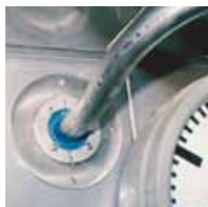
キッチンのスプリンクラー用に使われるRoxtec RSシール
