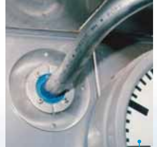
烙克赛克 RS 68 密封系统用于气动管线防震设备，透过生产平台上舱壁开孔密封。
