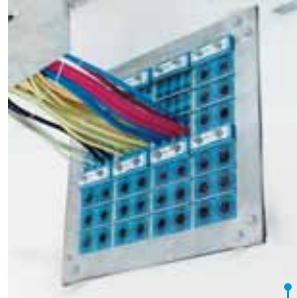
烙克赛克 G 6+6x4 密封系统用于防火要求的压缩机房。
