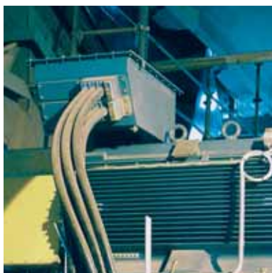
烙克赛克穿隔密封系统简化了电缆在压缩机中的安装工作。
