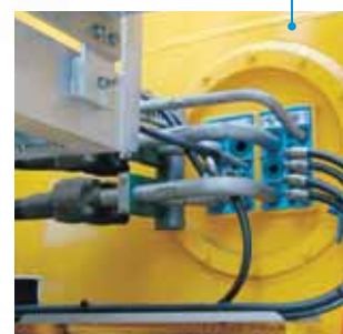
烙克赛克 S 6x2 工具用于生产平台上的离岸起重机之机房墙体气候防护和防震作用。
