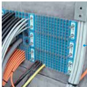
烙克赛克 G 8+8+8x3 穿隔密封系统用在炼油厂电缆从控制室外入室内的建筑墙体上,以达到防火要求。
