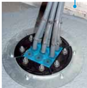
烙克赛克R型密封系统用于安装岸上变压器底部的防火设备。
