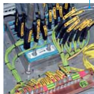
用于安装岸上箱柜底部屏蔽的烙克赛克EMC密封系统。
